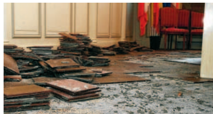
Le carrelage a été remplacé par un autre, provisoire ■ ARCH. FH
